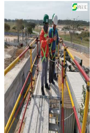
Làm việc > 2m phải mang dây an toàn móc vào vị trí an toàn
