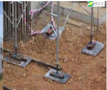
Kê lót: chân kích để điều chỉnh, lót xà gồ/ ván
