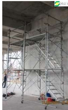
Đầy đủ thang, mâm thi công, lan can, sàn thao tác
