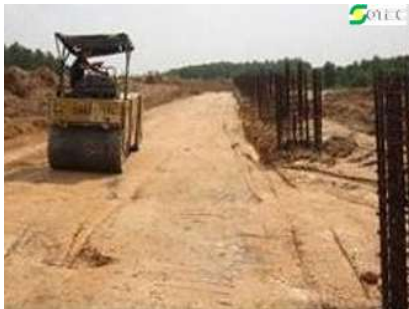
Nền đất được lu lèn chắc chắn
