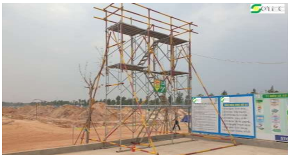
Giàn giáo được kiểm tra và treo thẻ: thẻ vàng đang lắp dựng, thẻ đỏ không được phép sử dụng, thẻ xanh an toàn sử dụng
